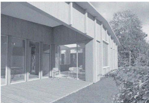
Loggia neuer Kindergarten
