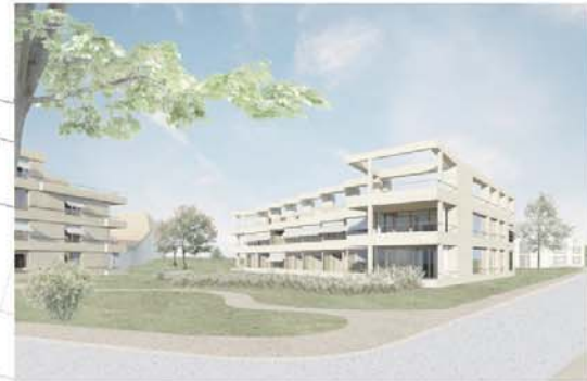
Blick vom Fritz-Ruffer-Weg nach Süd-West auf Erweiterung Rufferheim (Dahlhölzl)
